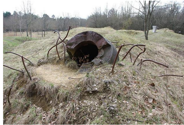
Die zerschlagene Beobachtungspanzerkuppel des Ouvrage 1
